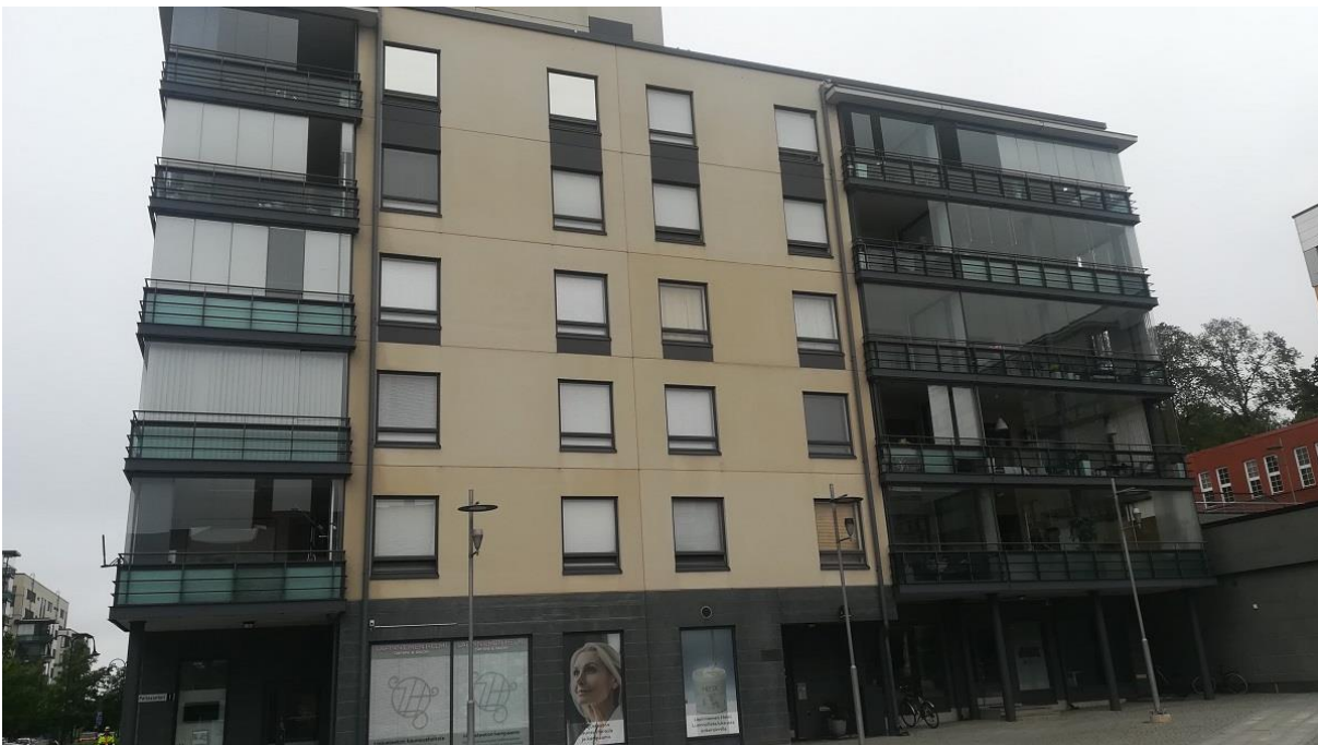
Kuva 2. Yleiskuva julkisivusta ja parvekkeista.
