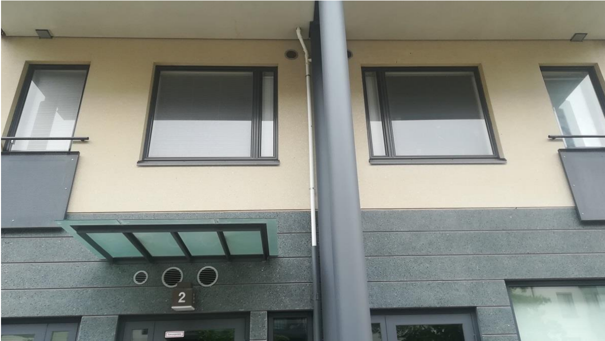
Kuva 3. Liikehuoneistojen LTO-kojeiden tuloilman ottoaukot ulkoseinässä.
