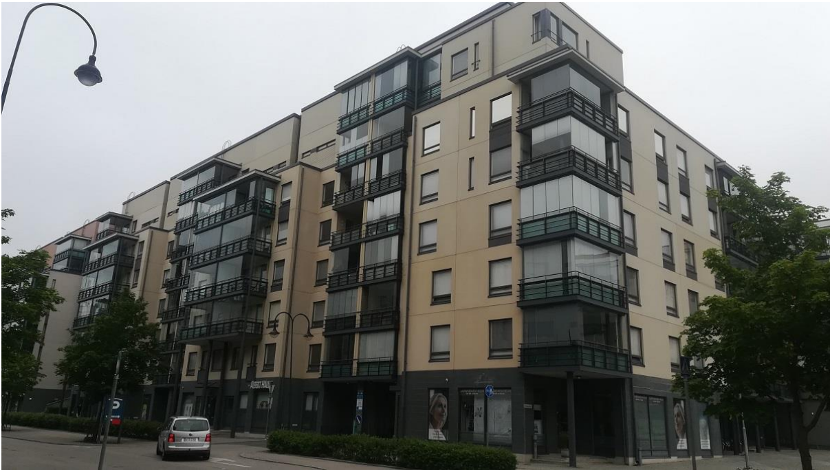
Kuva 1. Yleiskuva julkisivusta ja parvekkeista.
